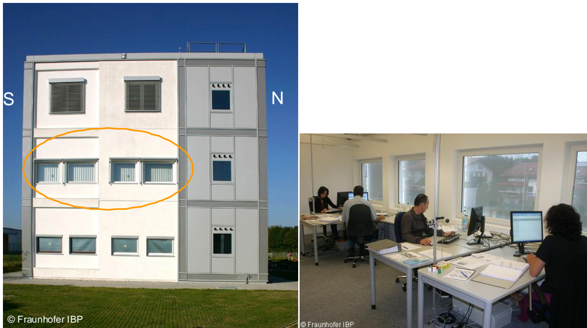
Abb. 5.1 Links : Ansicht der Fassade des Versuchsgebäudes und Kennzeichnung des Versuchsraumes. Rechts : Ansicht des Versuchsraumes von innen mit arbeitenden Probanden
