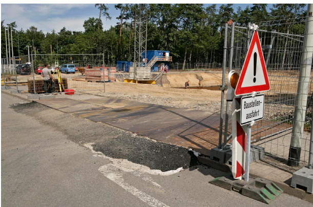
Abb.: 1 Oberflächenschutz einer Baustellenzufahrt im Bereich eines Gehweges, bestehend aus Vlies, Bitumenauflage und Stahlplatten
