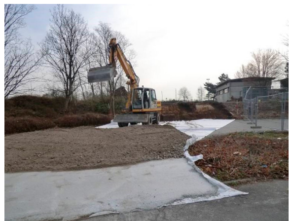
Abb.: 2 Baustraße aus Mineralgemisch und Beton auf einem Geotextil als Trennlage
