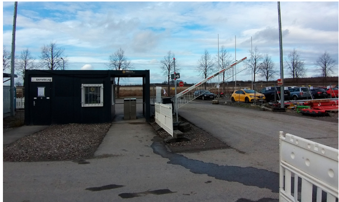
Abb.: 3 Gesicherte Baustellenzufahrt mit getrennter Führung von Baustraße und Bauweg
