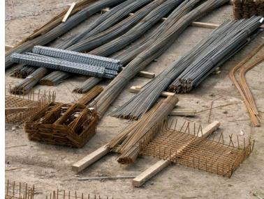
Abb.: 8 Lagerfläche für Bewehrungsstahl (teilweise unsachgemäß)
