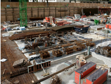
Abb.: 7 Lagerflächen im Schwenkbereich des Krans
