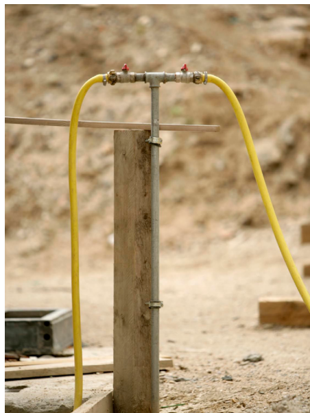
Abb. 2: Wasserzapfstelle
