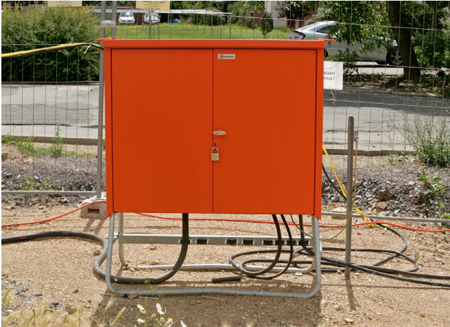
Abb. 3: Stromversorgung der Baustelle mit abschließbarem Anschlusschrank
