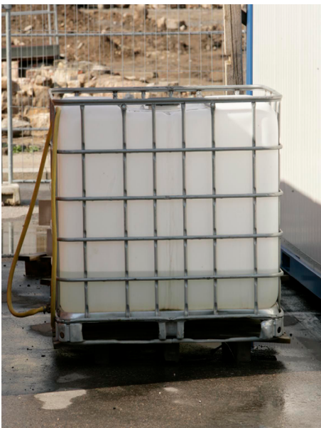
Abb. 1: Baustellen-Wasserversorgung für Wasch- und Brauchwasser mittels transportablem Wassertank [ca. 1 m 3 ]
