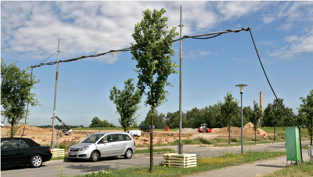
Abb. 7: Leitungsbrücke für Leitungsführung
