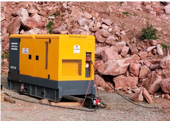
Abb. 4: Energieerzeugung durch Dieselgenerator
