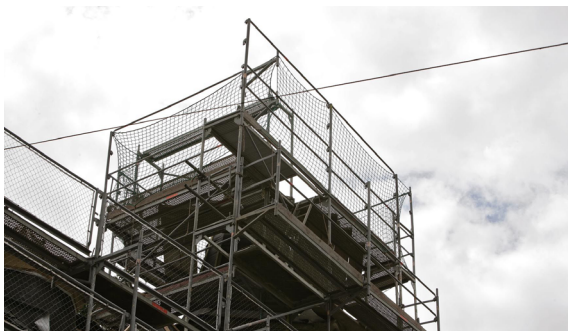
Abb. 2: Schutzgerüst als Dachfanggerüst
