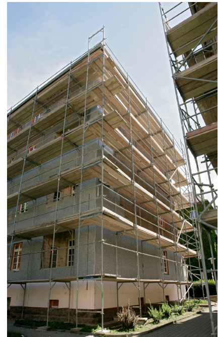
Abb. 1: Arbeitsgerüst als Fassadenstandgerüst
