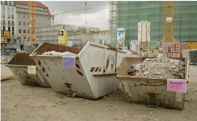
Abb 1: Beschriftete Container zur Getrennthaltung von Bauabfällen
