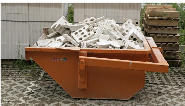
Abb 2: Einsatz von kranbaren Schuttmulden
