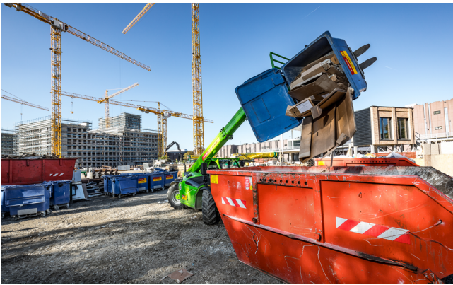
Abb. 3: Abfalltrennung und Abfalltransport als Teil der Baulogistik
