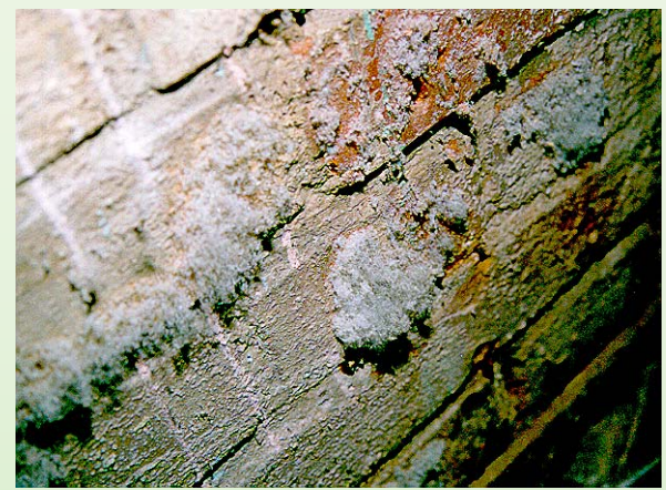
© TLA tV : Innenwandbereich eines Archivs
