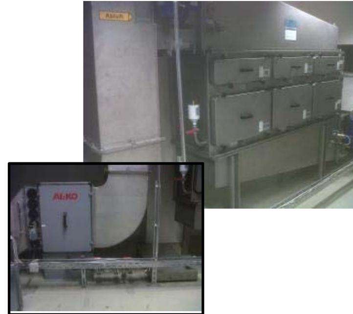
Wasserabscheider vor dem HEPA-Filter der Abluft mit geschlossener Ableitung und autoklavierbarem Wasseraufnahmebehälter.
