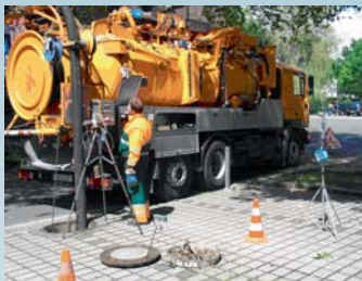
Messungen zum Vergleich der Konzentration – Kanalspülung mit einem Hochdruckspülwagen
