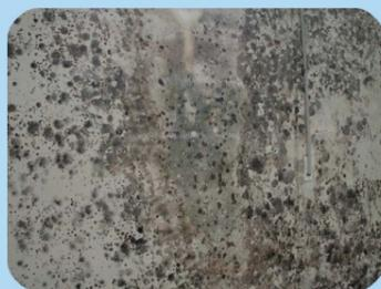
Abb. 1: Schimmelpilzbefall, Sanierungsobjekt
