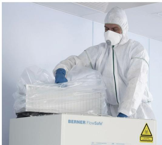
Die zu inaktivierenden Filterelemente aus einer HEPA-Hauptfilterstufe dürfen eine bestimmte Größe, gem. der Definition des kontaminationsarmen Filterwechsels, nicht überschreiten. Explizit ist aber keine maximale Größe festgelegt. Die Bestimmung, dass die Filterelemente in übliche Abfallentsorgungsbehälter passen müssen, hilft hier.
