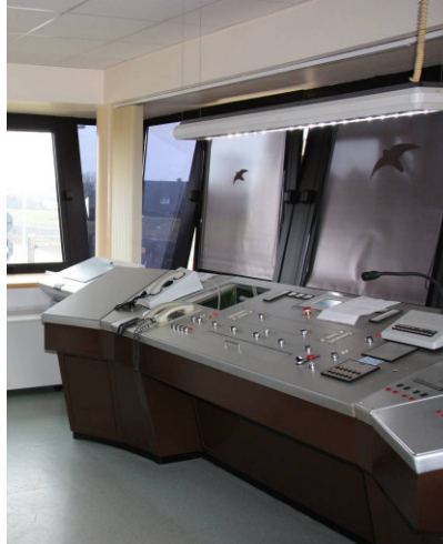
Leitzentrale Herburn: Alter Steuerstand Detail: Zweihandbedienung Bilder mit freundlicher Genehmigung der WSV!
