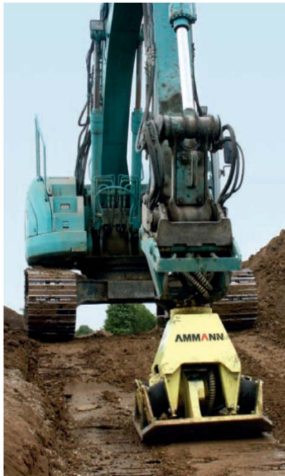
Rüttelplatte am Baggerausleger
