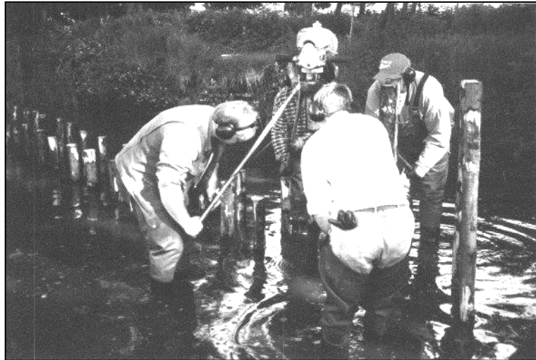
Abbildung 8.2 Pfahlrammen mit Wacker an einer Uferböschung (Arbeitsablauf vor der Gefährdungsbeurteilung)
