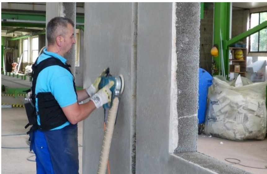
Abbildung 19: Nachbearbeitung einer Fertigbauwand mit einem abgesaugten Tellerschleifer
