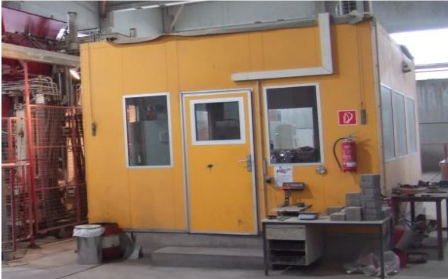
Abbildung 14: Steuerstand mit einer technischen Lüftung
