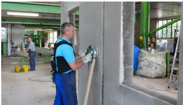
Abbildung 10: Nachbearbeitung einer Fertigwand
