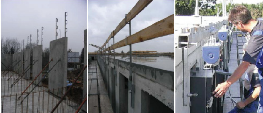
Vormontierte Seitenschutzpfosten (Bild 1, Bild 2); Montage der Fensterleibung (Bild 3) 1
