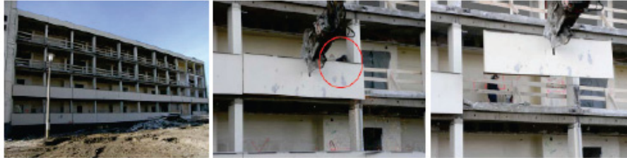
Demontage der Brüstungselemente 1
