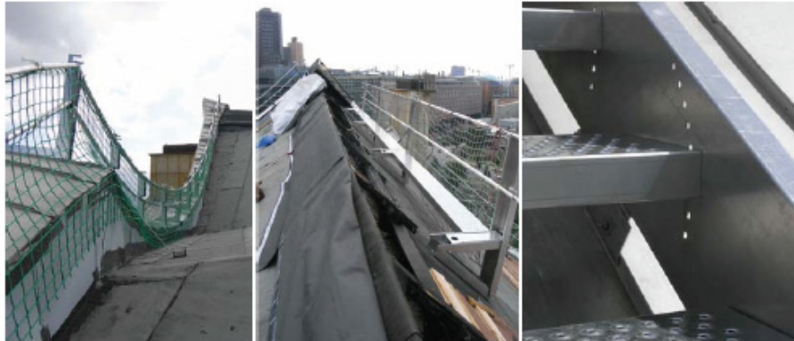
Flexibler Seitenschutz (Bild 1), Variables Arbeitsgerüst (Bild 2), Verstellbare Stufen (Bild 3) 1
