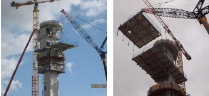
Einheben der vormontierten Boden- und Deckenelemente der Plattform 1
