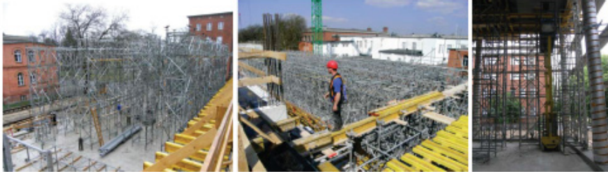
Schalarbeiten für die Betonage einer hochliegenden Decke 1
