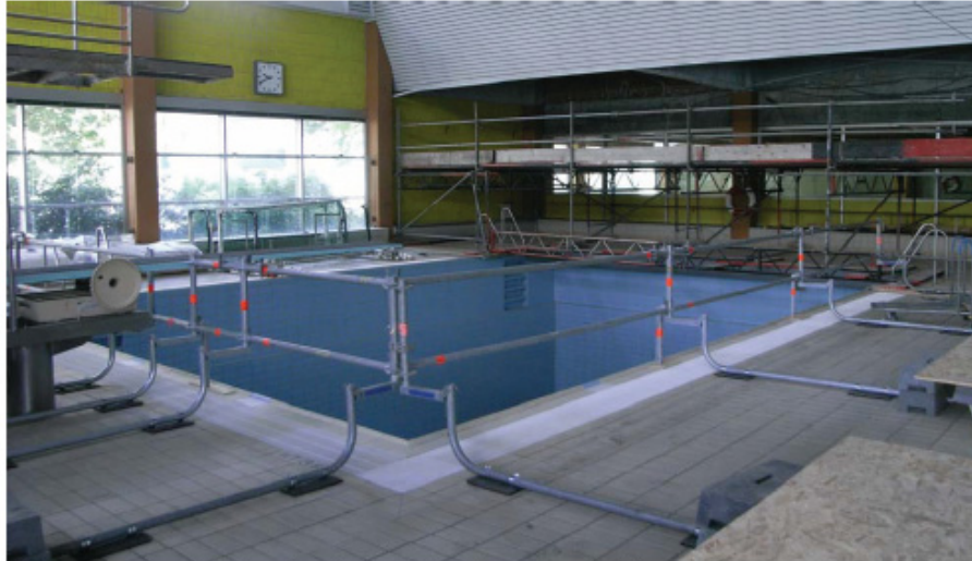
Absperrung des Schwimmbeckens durch selbsttragende Absturzsicherungen 1
