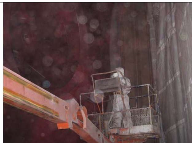
Sprühvorgang: Rechts abgespannte Plane
