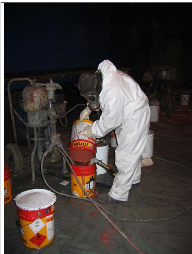
Umfüllen der Farbe in den Ansatzbehälter
