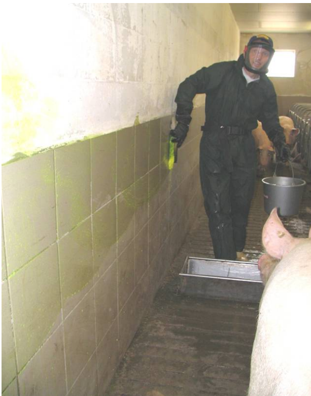
Abb. 6.16 Goldin wird als wässrige Suspension mit Bürste auf die Stallwand aufgestrichen
