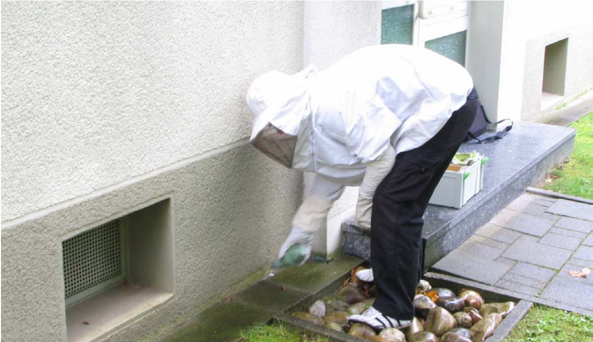
Abb. 6.13 Wespenbekämpfung mit Stäubepreparat mittels Puderbalg (das Wespennest befindet sich hinter der Fassade; (bei dieser Maßnahme wurde ausschließlich nach unten gestäubt, sodass vom Techniker kein Atemschutz für notwendig erachtet wurde)
