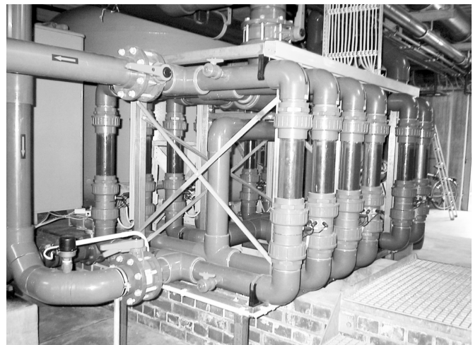
Anodische Durchfluss-Elektrolysechlorung: Inhärent sicherer Stand der Technik bei der Chlorung von Solebädern. Bild: Reinhold Zirbs
