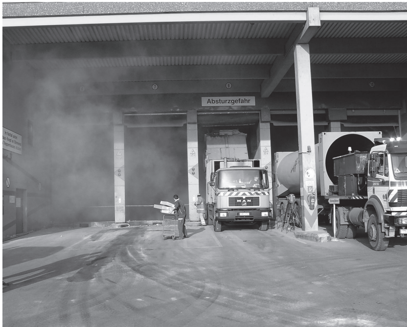
Bild 1. Arbeitsplatzmessung bei der Abfallanlieferung in einem teilweise geschlossenen Arbeitsbereich.
