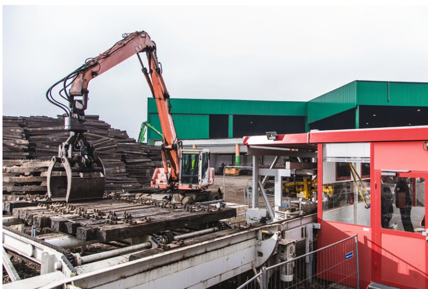
Abb. 1 ▲ Abplattenanlage mit schutzbelüfteter Kabine. (© Autor)
