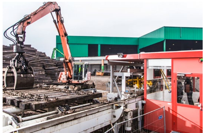
Abb. 2: Abplattenanlage in Betrieb 1 mit schutzbelüfteter klimatisierter Abplattkabine
