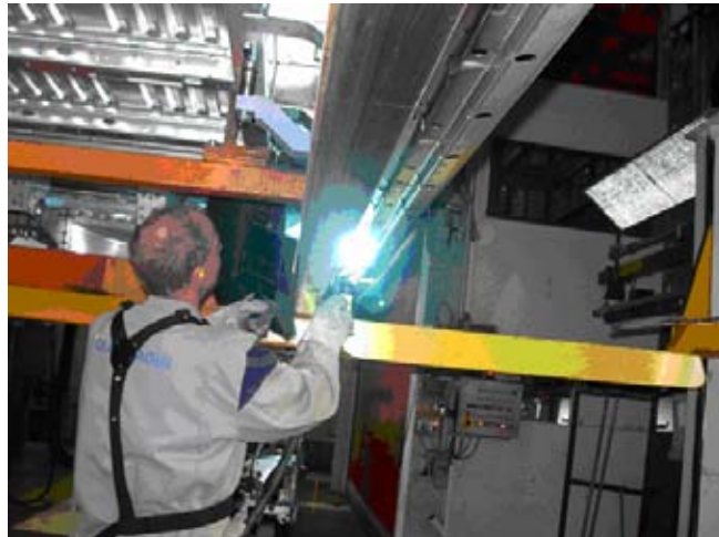
Anh. 3, Abb. 8 MIG-Löten über Kopf. Bei diesem Arbeitsvorgang wurde aufgrund technischer Schwierigkeiten nach einem ersten Versuch auf weitere Probenahmen verzichtet.
