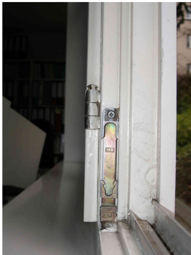
Abb. 5.9 Das untere Fensterrahmenprofil
