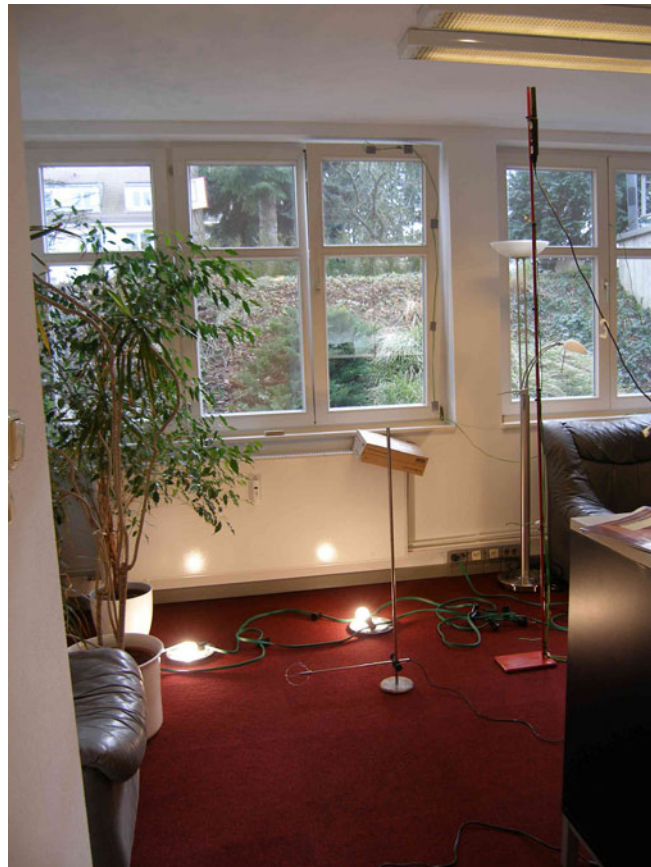
Abb. 5.11 Blick in den Raum vor den Fensterflügeln 13 bis 16 (17)
