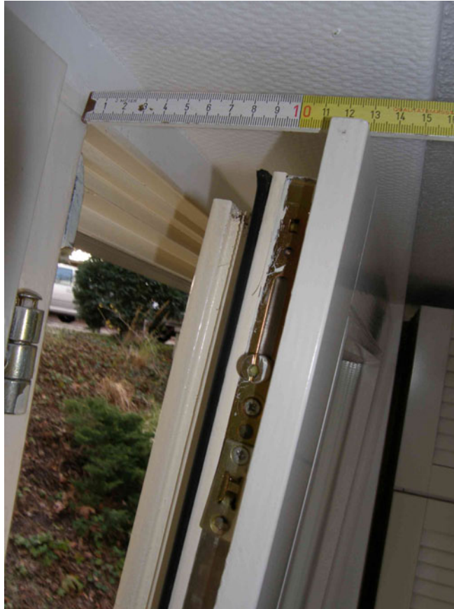
Abb. 5.6 Seitenansicht eines gekippten Flügels, Kippstellung k = 13 cm, Kippweite s = 6,5 cm
