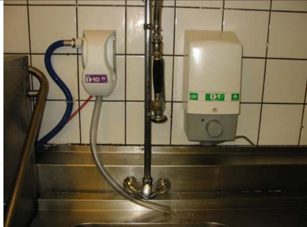
Eine weitere Entnahme ist an der Spüle gegeben. Hier wird das Konzentrat beim Öffnen des Wasserhahns mit Hilfe des „QFM-Dosiergeräts“ sofort dem Wasserstrahl zugegeben, sodass auch hier kein Kontakt mit dem Konzentrat erfolgt.
