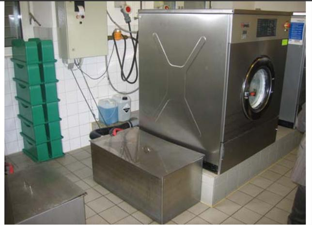
Waschmaschine mit Behälter für Vorwaschlauge
