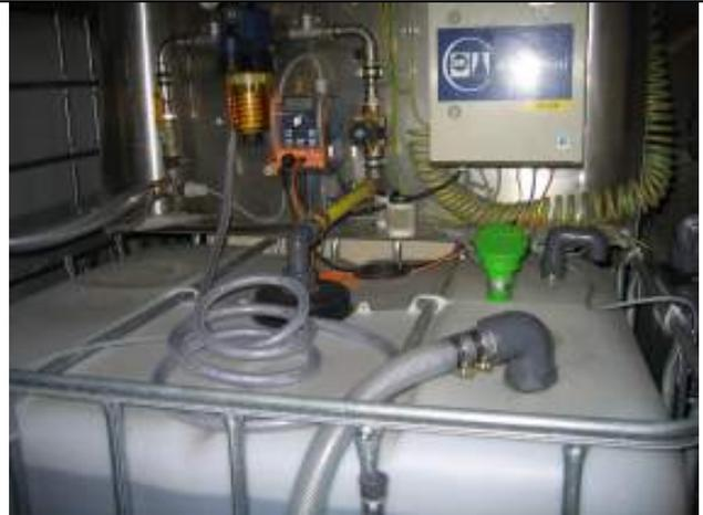
Entnahmevorrichtung; Schlauch im Vordergrund: Umfüllpumpe
