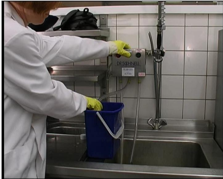
**Abb. 10.3** Automatische Zudosierung zum Wasserstrahl
