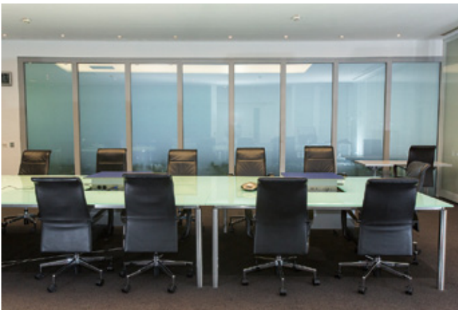
Abb. 4 Elektrochromes Glas/Raum mit Blick auf Wartenraum
