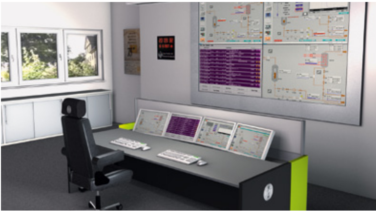
Abb. 9 Leitwarte mit kombinierten Großbildschirmen und kleineren Monitoren
